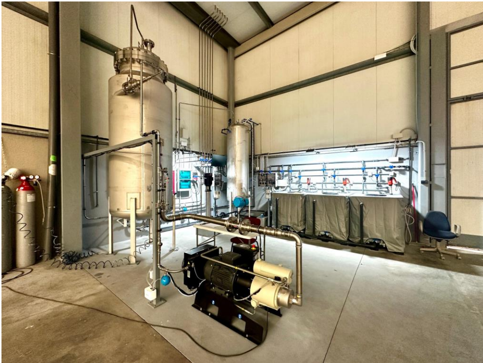
Pilot egylépcsős biogáz-mélytisztító rendszer CO 2 -hasznosítással és hasznos melléktermék-előállításal Spanyolországban
